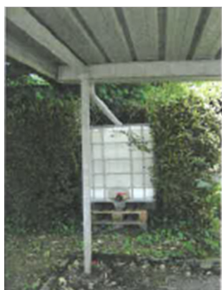
Cuves de récupération des eaux de toitures des abris à vélo et poulailler
