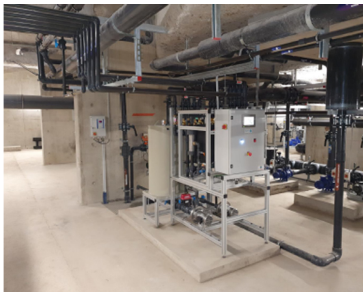
Solution de récupération des calories
